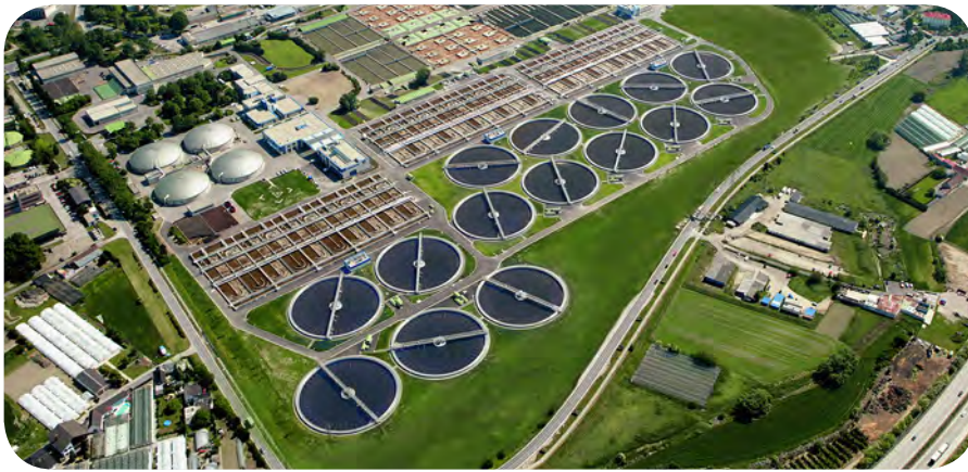
Kommunale Kläranlage Wien, Austria
