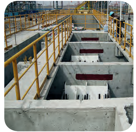
CPI-Öl/Wasserabscheider
