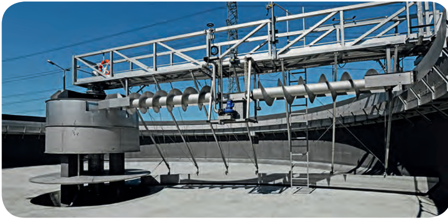
Patentierter Schwimm Schlamm-Schnecke mit Abzugskasten mittig
