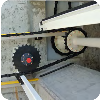
Flotaträumer komplett in Kunststoff
