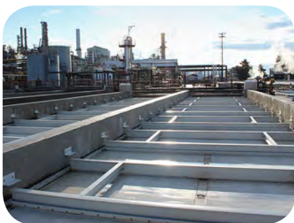
API-Becken mit schwimmenden Abdeckungen
