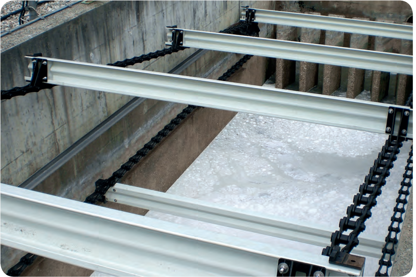
Oberflächenräumer für Industrieanwendungen
