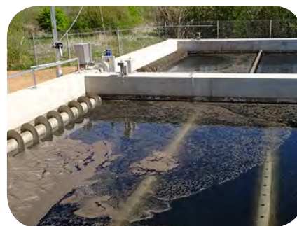
Rechteckbecken mit getauchten Ablaufrohren und Schnecken für Schwimmschlammabzug
