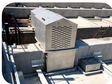
API-Becken, gasdicht
