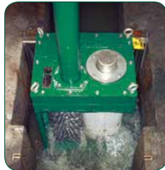
Meglévő aprító kiváltása CMD típusú Channel Monster-rel.
