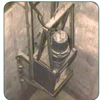
Átemelőbe épített Channel Monster. (vezetősínen leereszthető).
