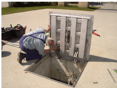
Nachträglicher Einbau einer Fluchtentriegelung vor Ort
